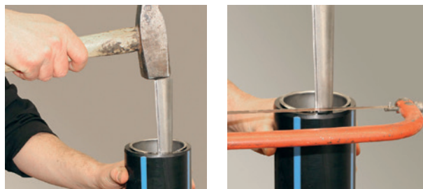
6. Spreizkeil bis zum Verspannen in die Stützhülse einschlagen. Überstehendes Spreizkeilende bündig mit der Buchse abschneiden.
