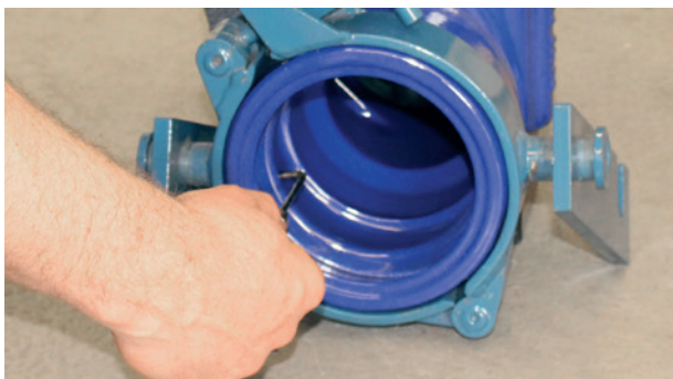
1. Muffe und Einsteckende reinigen.
