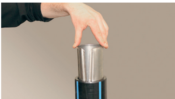
4. Einsteckende des Rohres abrunden.
