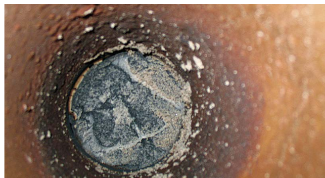
Nach dem Versuch (vom Intumeszenzmaterial verschlossene Rohrleitung)
