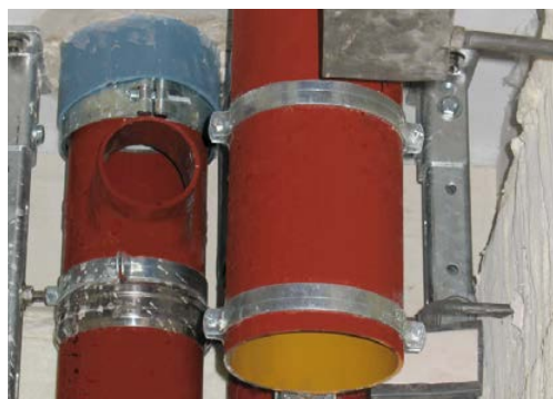
Vor dem Brandversuch (unter der Decke)
