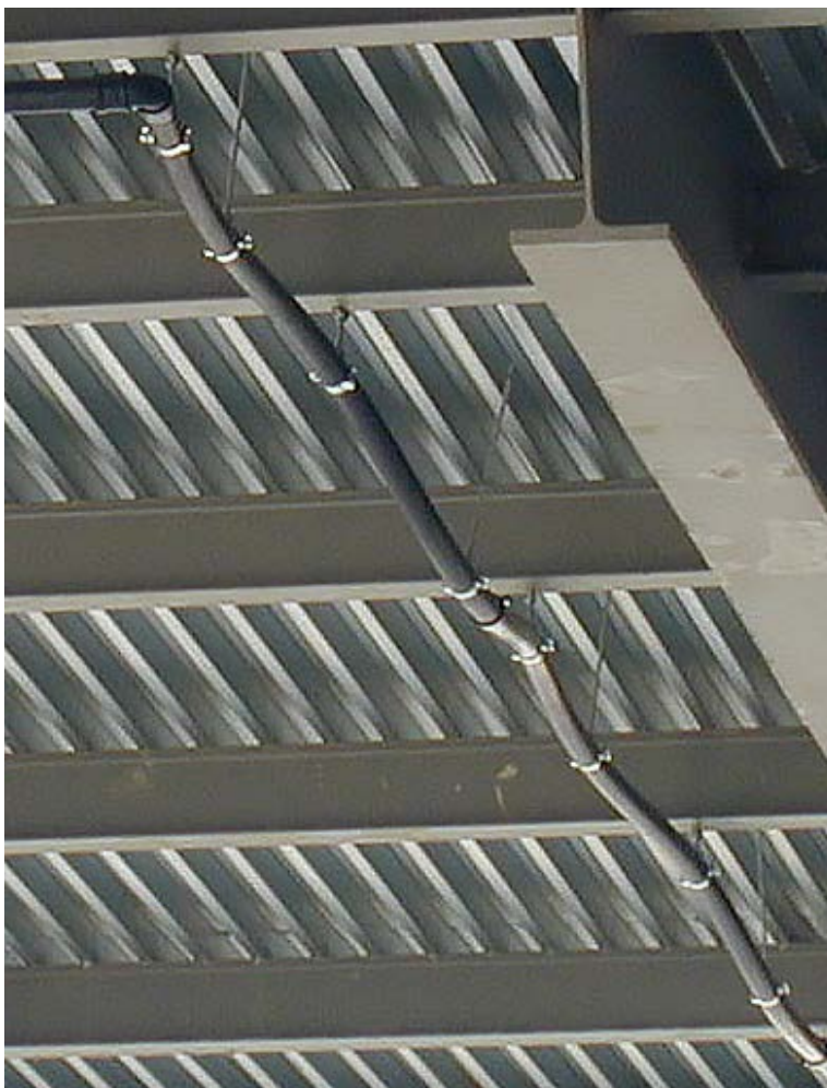
Probleme durch Längenausdehnung: durch Hitze verformte Kunststoffrohre unter einem Hallendach – mit Düker Gussrohren wäre das nicht passiert!
